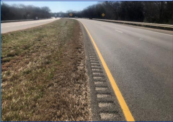
Edge line Rumble Strips
